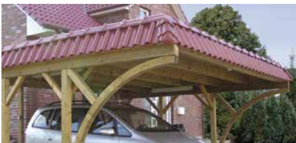
Breite Einfahrt: Pfostenbogen aus Leimholz
