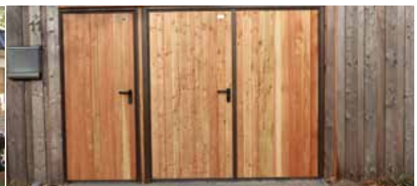
12 13 Beplankt mit ca. 19,5 mm Softline Rundkanten Profilbrettern, Metallrahmen RAL 8028 Terrabraun, DIN links/rechts möglich
