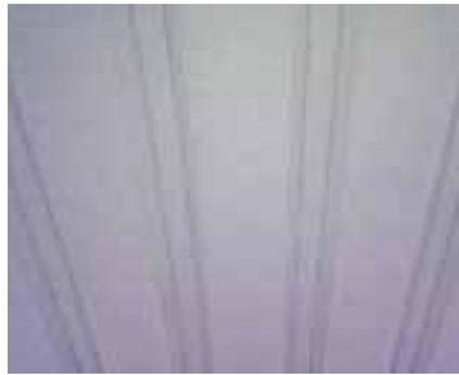
**T** Mit Stahl-Trapezplatten mit tropfhemmender Unterseite (s. Abbildung)
