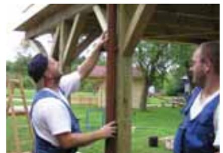
**9** Die Dachrinnen-Anlage: Das Wasserlauf-Set zusammenbauen und zwischen den mittleren Pfetten einsetzen.
