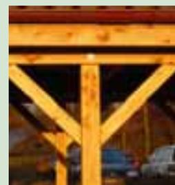
**4** Längs-Kopfband links u. rechts. Statisch bedeutend als Aussteifung Ihres Carports in Längsrichtung.
