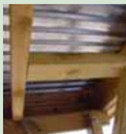
**3** Kopfband-Wechsel – dient zwischen den Pfetten als Anschlagspunkt für das Quer-Kopfband.
