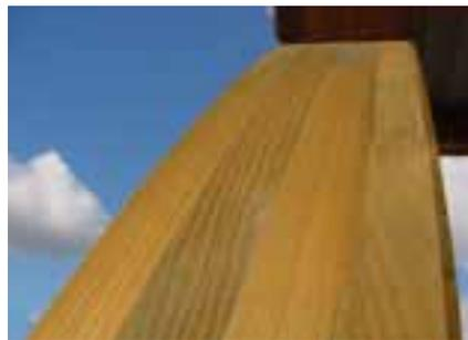
1 Pfostenbögen aus hochwertigem Leimholz (BSH) gefertigt. Abbildung: Classic-Variante.
