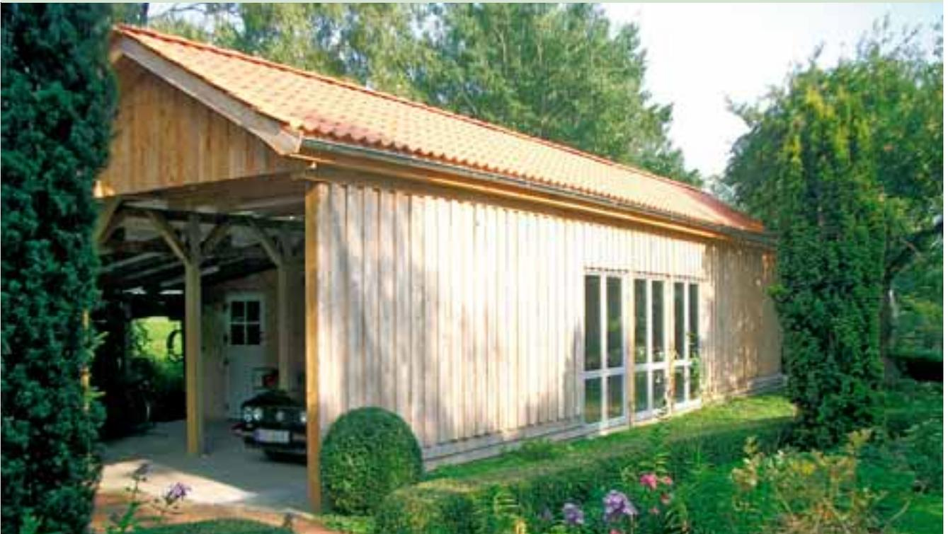
Satteldach-Carportlösung mit individueller Wandgestaltung (sogenannter Boden-Deckel-Schalung).
