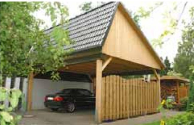
*Flexibel schräg und hoch hinaus: asymmetrisches Satteldach – eine Lösung passend zur Dachneigung des Wohnhauses.*
