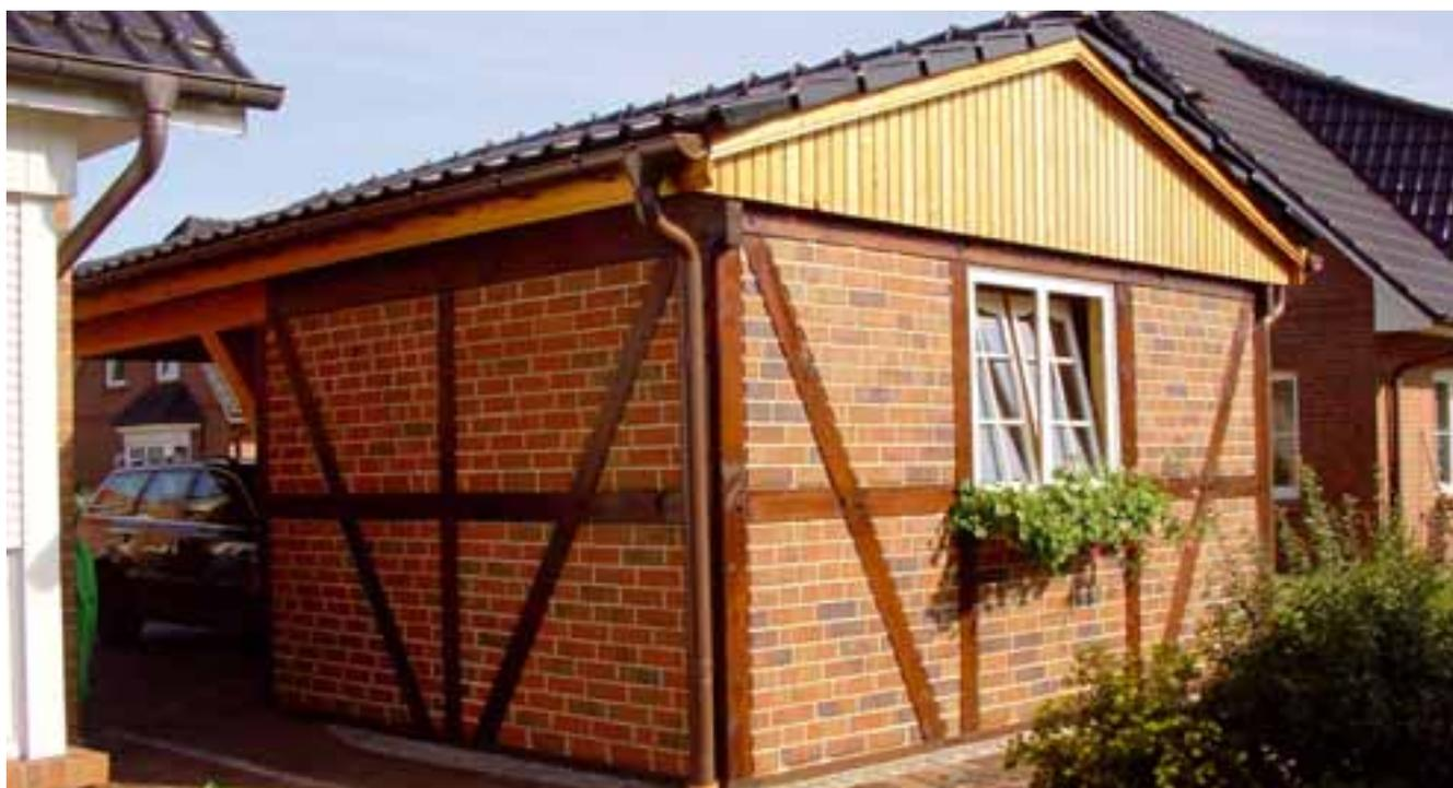
Bewährtes Zimmermann-Handwerk für die Wand: Fachwerk (Hölzer hier bauseits lasiert und ausgefacht) schließt das Carport. Angenehmer Effekt: Die Stabilität bzgl. Winddruck und Schneelasten erhöht sich. Abbildung zeigt Sondermodell der Natur-Serie.
