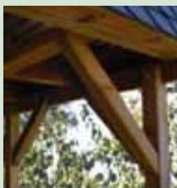
**2** Quer-Kopfband für Front- und Giebelseite zur zusätzlichen Aussteifung und optischen Aufwertung.
