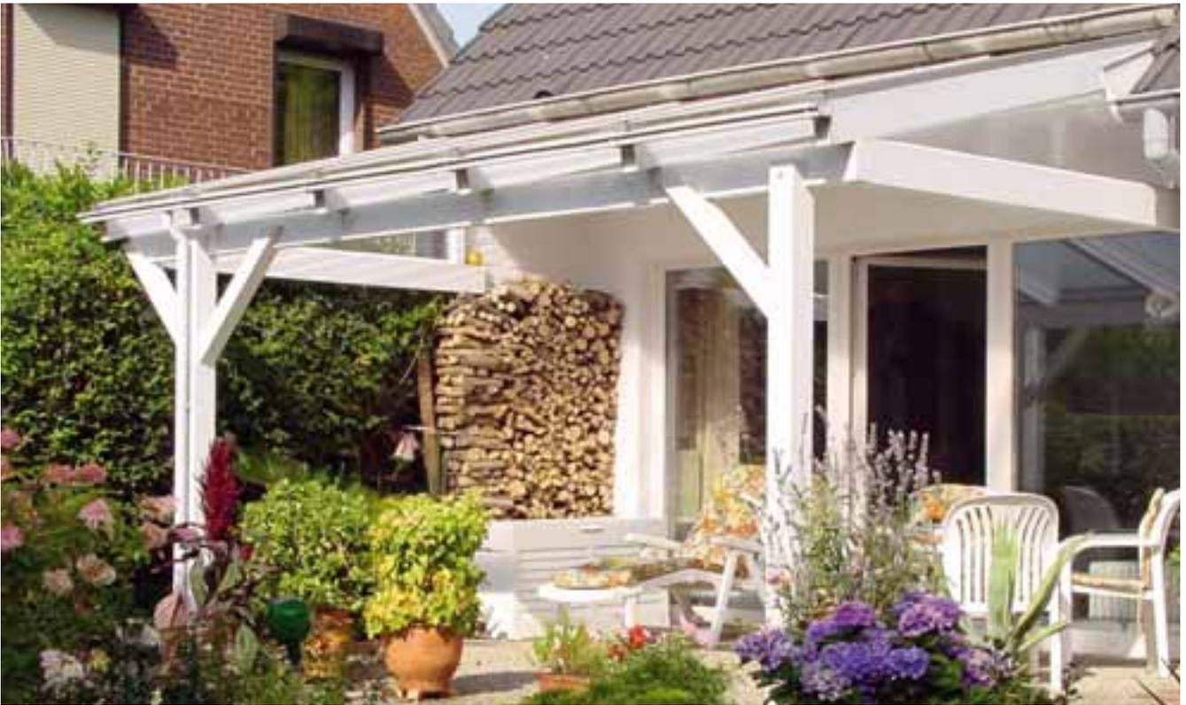
Sonderanfertigung, aufgrund geringer Traufhöhe bauseits mit Dachanschluss.
