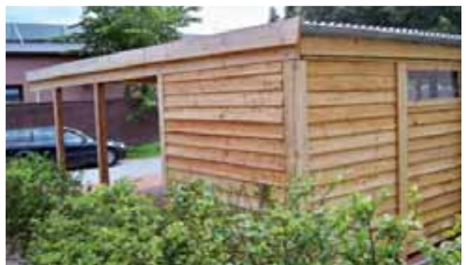
Belastbar: Verkleidung mit rustikalem Wechselfalz-Profil. Abbildung zeigt Natur-Variante aus Lärche.
