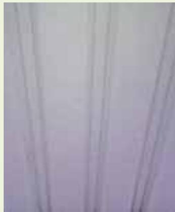
5 Mit Filz: Die Plattenunterseite ist Kondensat-tropfhemmend beschichtet.
