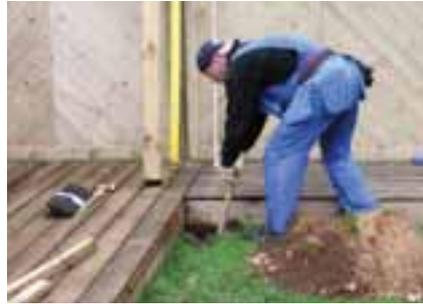
**2** Erdarbeiten: Heben Sie Erdlöcher zur Aufnahme der Fundamente bzw. Pfosten aus – ggf. groben Kies in die Löcher einfüllen.
