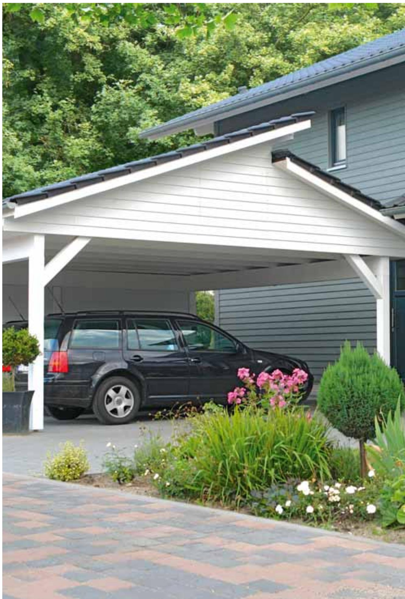
Bei dieser nach Kundenwunsch gearbeiteten Carport-Lösung folgt die Neigung des versetzten Pultdaches der Dachneigung des Wohngebäudes.
