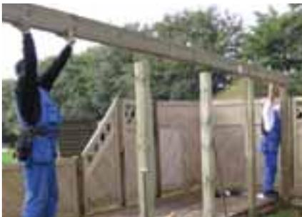
**4** Sattelbalken auf Pfosten legen und verschrauben. Tipp: vorher Winkel zur Pfettenmontage befestigen. Danach Längskopfbänder anschrauben.
