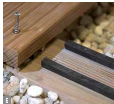
6 Praktisch: Selbstklebendes Ausgleichsband reguliert Unebenheiten.
