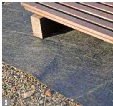
5 Wasserdurchlässiges Abdeckvlies gegen Durchwurzelung und Pfützenbildung.
