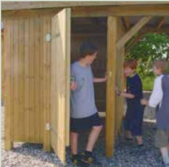
**8** Einzeltür, Massivholzrahmen mit Profiltrettern 19,5 × 96 mm, inklusive verzinkter Beschläge.
