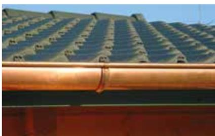
**4** Edel und wertbeständig: 8-teiliger Dachrinnen-Bausatz im Format NW 100 mm. Hochwertig aus Kupfer, passend für alle Satteldach-Carportbausätze. Die Verlötlung muss bauseits erfolgen.
