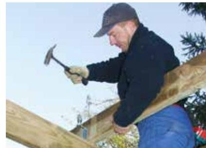
**5** Die von Joda® vorgefertigten Pfetten aufsetzen und annageln. Zwischen den mittleren, oben ausgefälzten Pfetten wird die Dachrinne eingehängt.
