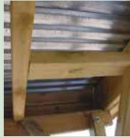
**3** Kopfband-Wechsel – dient zwischen den Pfetten als Anschlagpunkt für das Quer-Kopfband.
