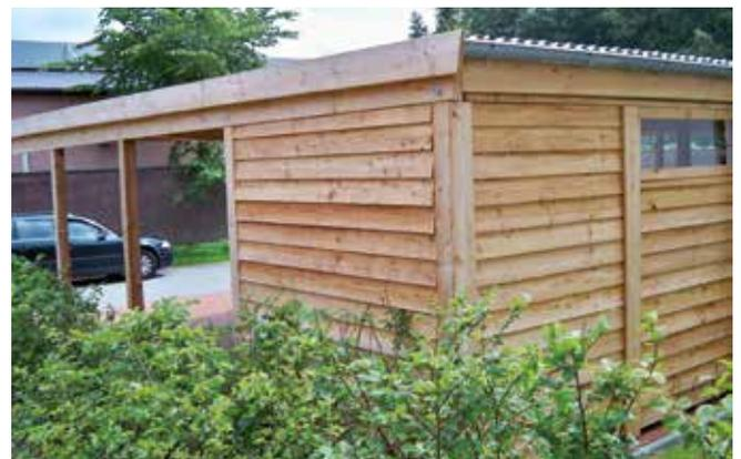
Belastbar: Verkleidung mit rustikalem Wechselfalz-Profil. Abbildung zeigt Natur-Variante aus Lärche.
