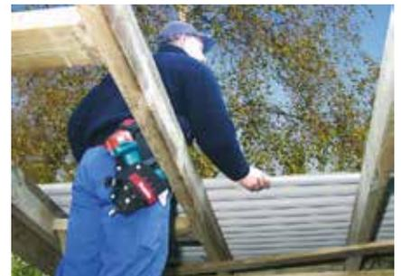
**6** Das Dach: hier Bedachung mit großformatigen Trapezblechen. Einfach auflegen, ausrichten und mit Spezialschrauben im „Tal“ festschrauben.
