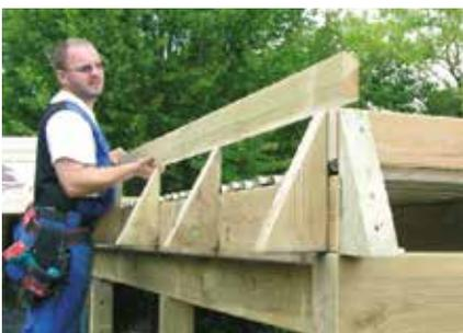
**7** Die Lücke oberhalb der Dachtafeln wird durch Aufkantungsbretter gefüllt. Diese dienen auch als Auflage für die Kranzleisten.
