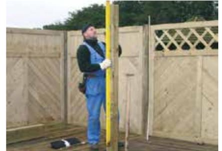
**3** Mithilfe von Wasserwaage und Schnur die Fundamente/Pfosten lotrecht in die Flucht setzen. Abstände genau prüfen u. ausrichten.
