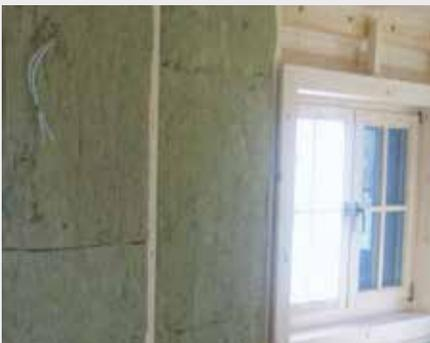
„Winterfest-Option“: doppelschalige Außenwand mit innenliegender Dämmung
