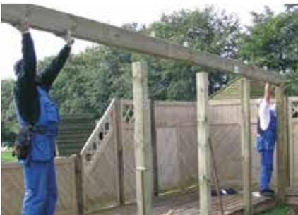
**4** Sattelbalken auf Pfosten legen und verschrauben. Tipp: vorher Winkel zur Pfettenmontage befestigen. Danach Längskopfbänder anschrauben.
