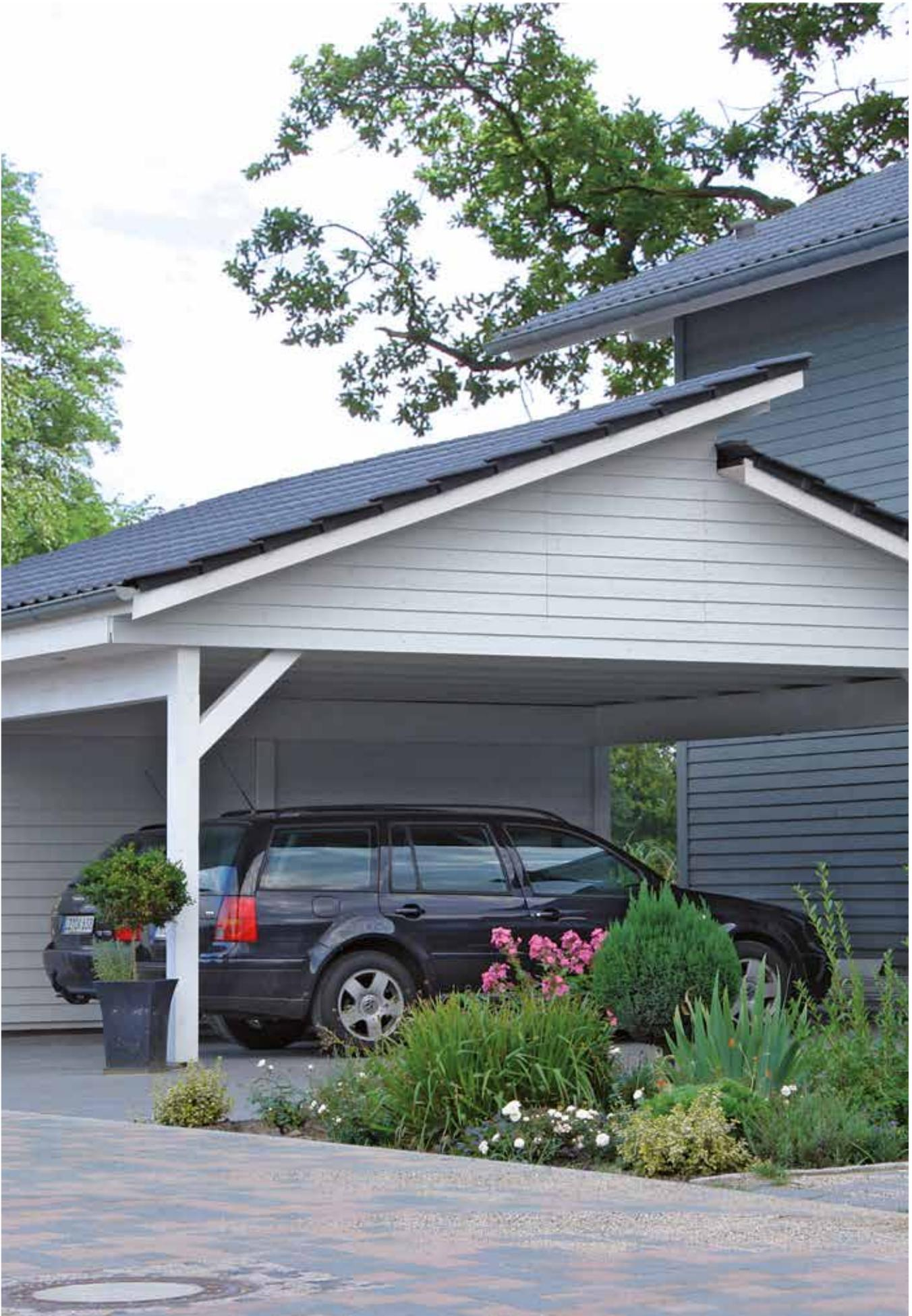
*Bei dieser nach Kundenwunsch gearbeiteten Carport-Lösung folgt die Neigung des Pultdaches der Dachneigung des Wohngebäudes.*
