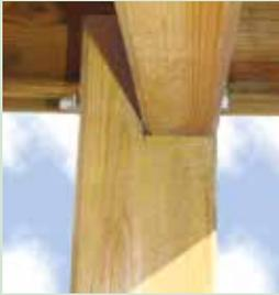
**1** Gehobelter Pfosten, bereits ausgeklinkt zur sicheren Aufnahme des Sattelbalkens.
