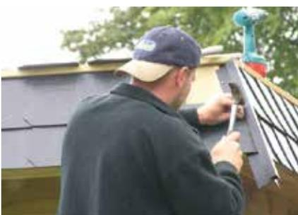
**10** Die Blendenbekleidung: hier Deckung mit Faserzement-Schindeln. Sauberer Abschluss durch Kantenprofile.
