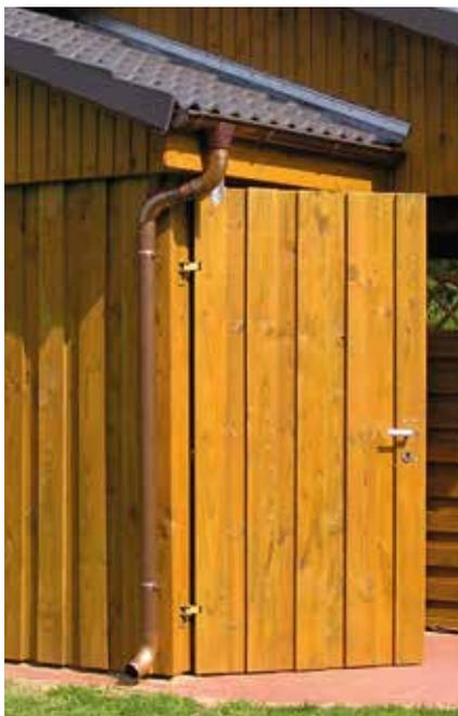
**4** Edel und wertbeständig: 8-teiliger Dachrinnen-Bausatz im Format NW 100 mm. Hochwertig aus Kupfer, passend für alle Satteldach-Carportbausätze. Die Verlötlung muss bauseits erfolgen.
