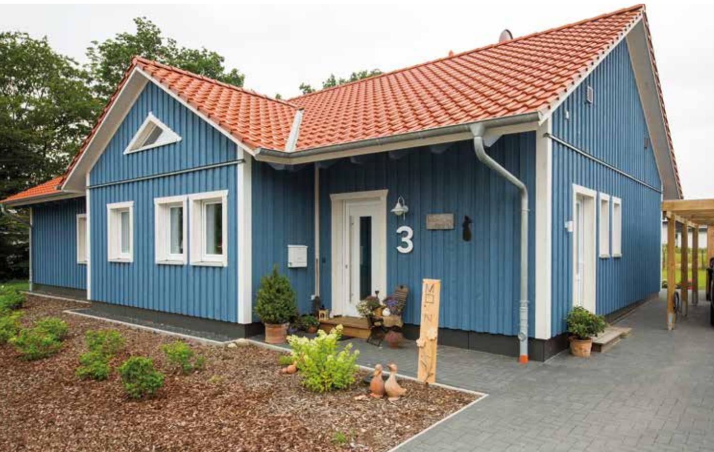
Durchdachter Grundriss -zeitlos gestaltet: 35°Satteldach mit Tonziegel, überdachter Eingang, modern-farbig abgesetzte Holzfassade.
