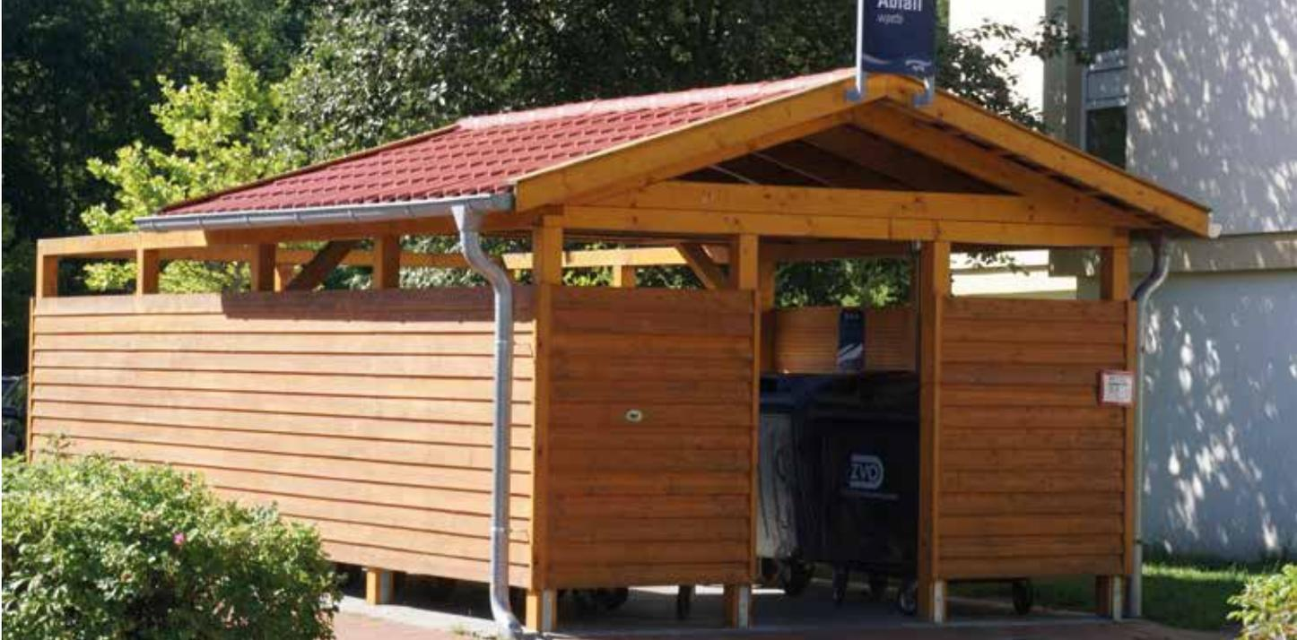
Unterstellplatz für Abfall, hier mit Wänden im Lärche Fassadenprofil N+F 29/15 × 141 mm
