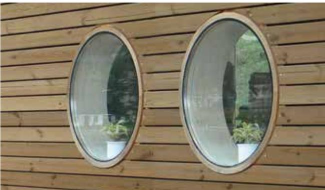
Schicke Schale für die Fassade – Rhombus-Profile aus Thermoholz
