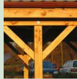
**4** Längs-Kopfband links u. rechts. Statisch bedeutend als Aussteifung Ihres Carports in Längsrichtung.
