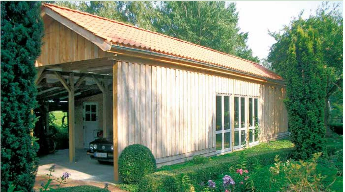
Satteldach-Carportlösung mit individueller Wandgestaltung (sogenannter Boden-Deckel-Schalung).
