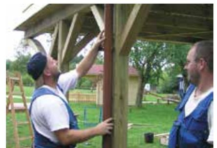
**9** Die Dachrinnen-Anlage: Das Wasserablauf-Set zusammenbauen und zwischen den mittigen Pfetten einsetzen.
