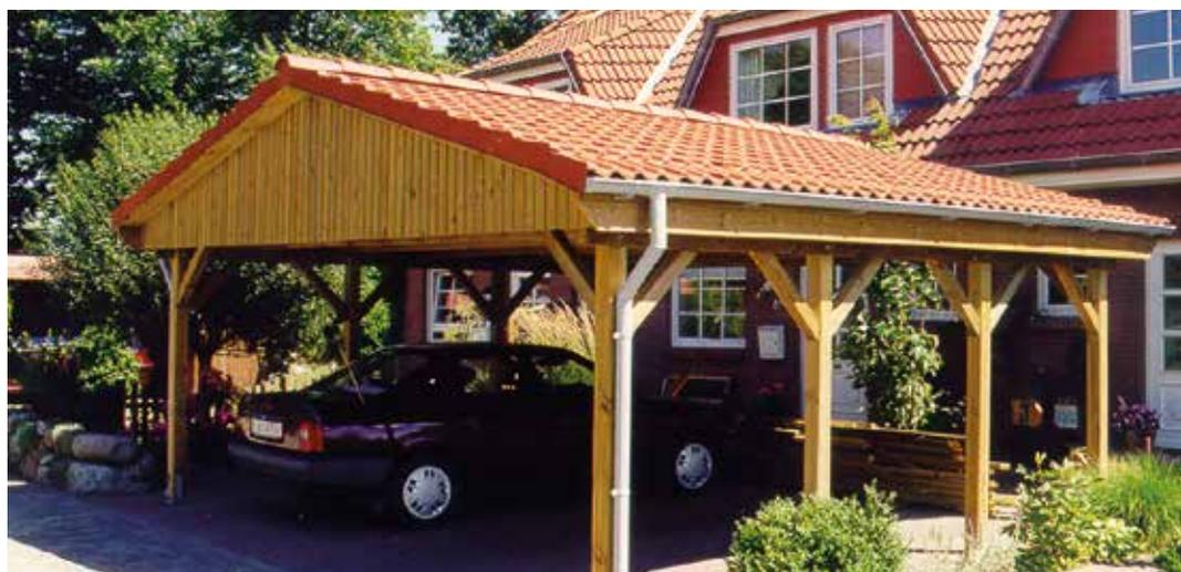
Doppelcarport Modell „Würzburg K“. Detail: Wasserablauf in Sonderfarbe; Dacheindeckung statt Ortgangblech (Standard) mit Ortgangpfanne.
