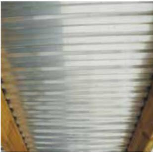
S // Stahl-Trapezplatten
