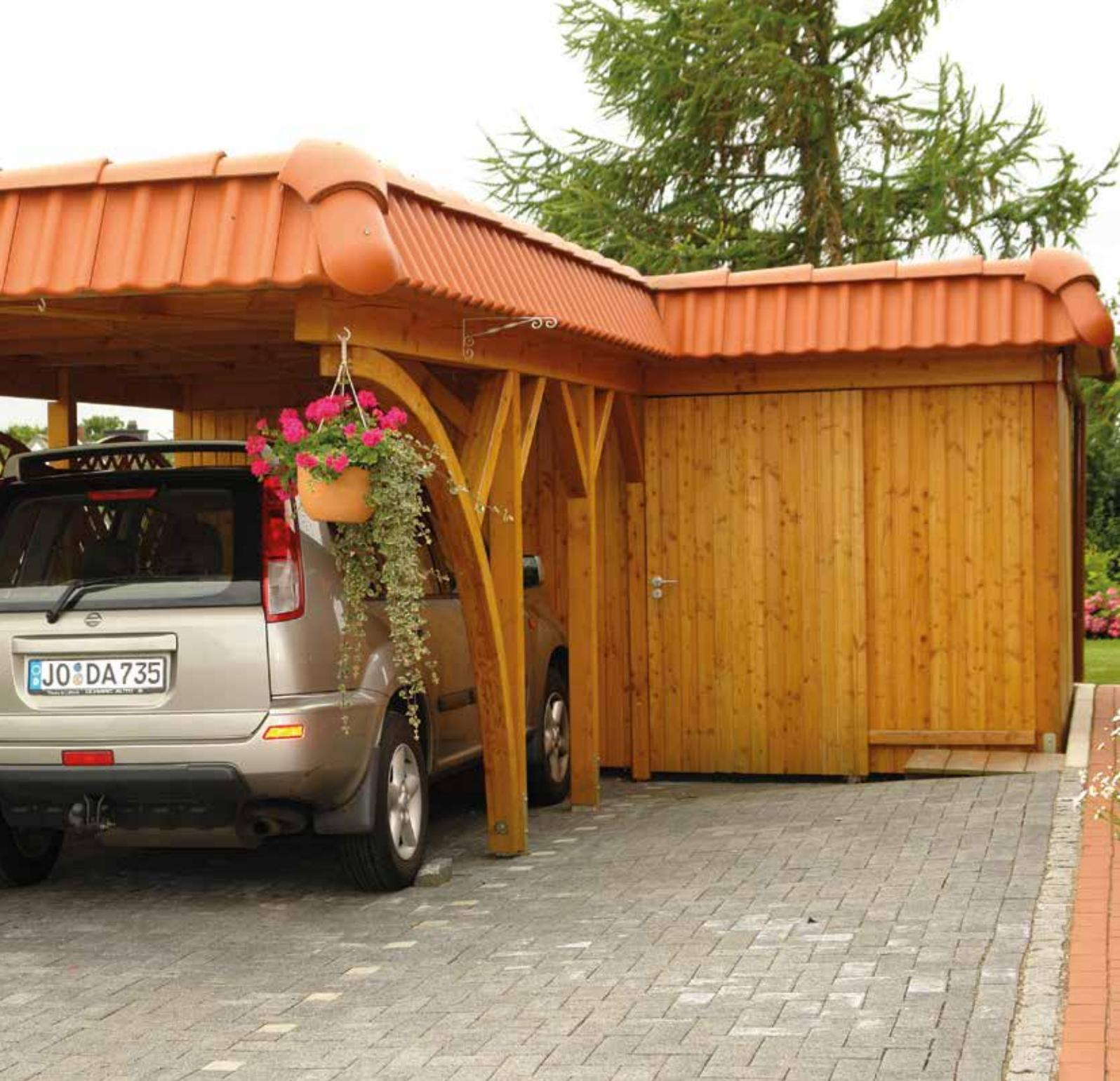
*Winkel-Carport: Sondermodell mit integrierter Kammer; Wandgestaltung mit Rundkanten-Profil aus Lärche natur.*
