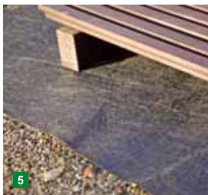
Wasserdurchlässiges Abdeckvlies gegen Durchwurzelung u. Pfützenbildung.
