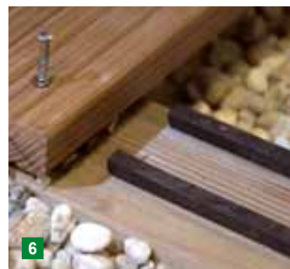
Praktisch: selbstklebendes Ausgleichsband reguliert Unebenheiten.
