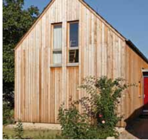
Moderne Fassadengestaltung mit Lärchenholz
