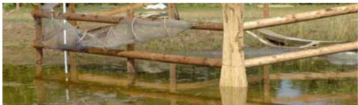
Frei von sogenannter Moderfäule: Thermoholz beweist auch bei Nässe Beständigkeit
