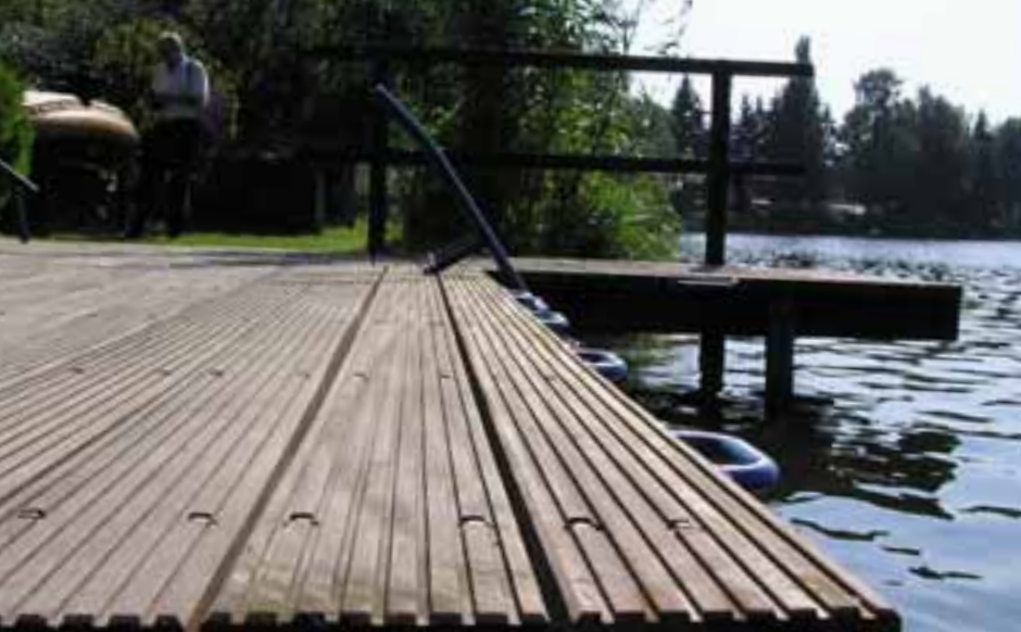
Unterkonstruktion im Wasser: Anwendungsbeispiel für Bongossi-Kantholz
