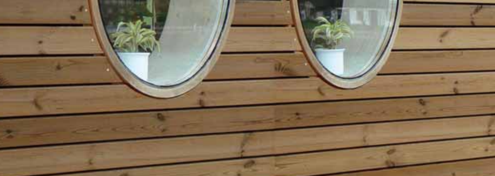
Modern aus Thermoholz: Auf Lücke gesetzte Fassadenprofile („Rhombus“)
