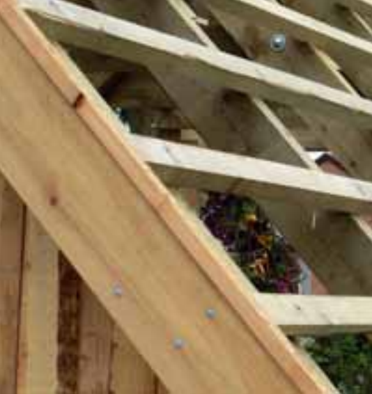
Lärche – Dachstuhl im Detail
